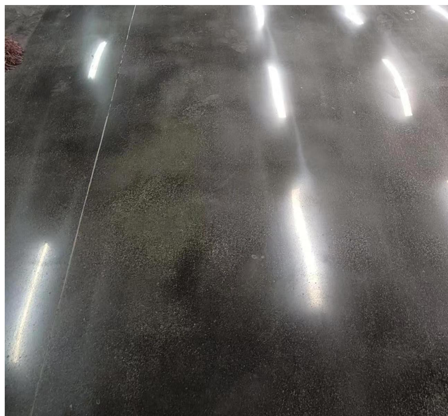
龟裂纹修补修补
