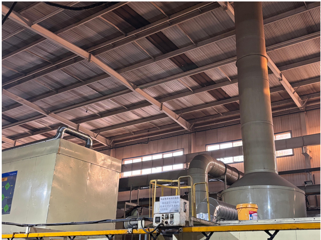
烟道拆除后现场（近）
