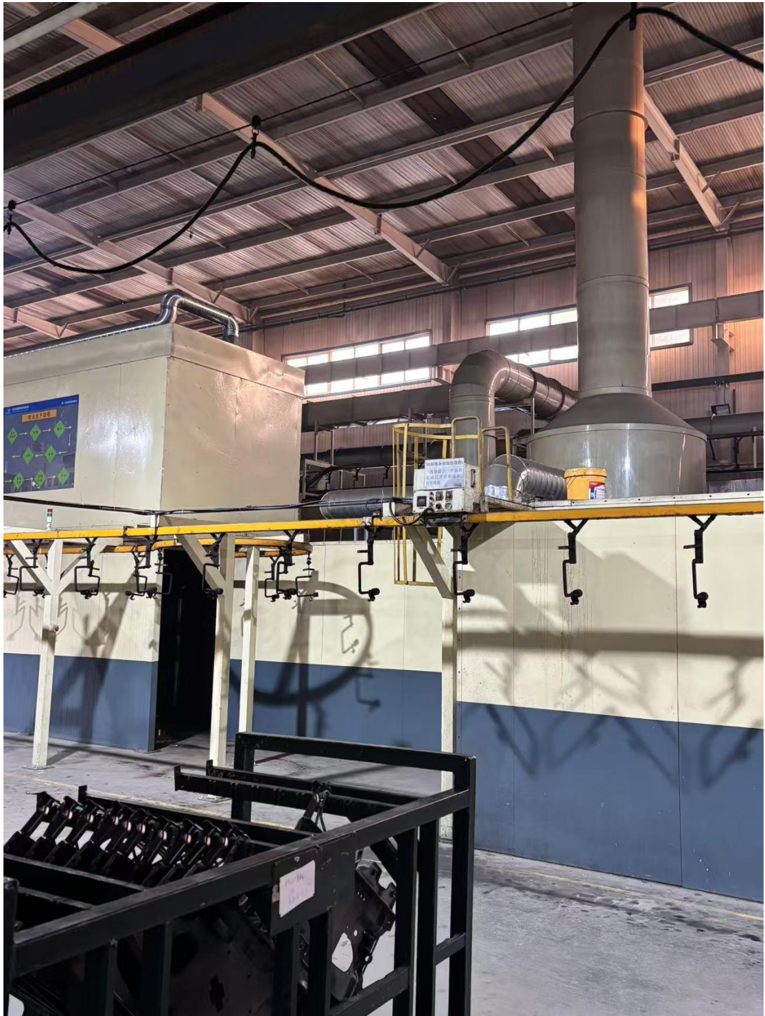
烟道拆除后现场（远）
