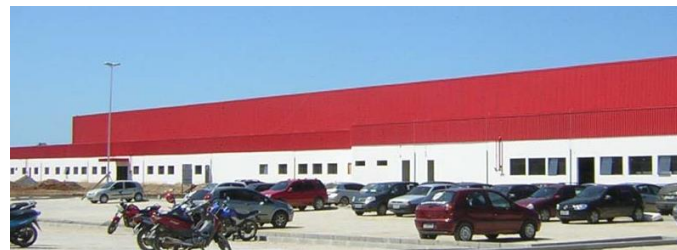
巴西 Navegantes 电机厂
